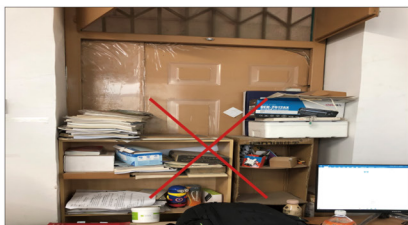
严禁堵塞消防通道
