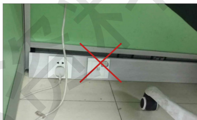
禁止使用有破损的插座
